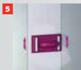
Pentru o suprafață perfect dreaptă cu îmbinări invizibile, plăcile de gips-carton trebuie să aibă minim 40cm lățime între margini; după ce ultimul strat de ipsos este aplicat și uscat, suprafața se șlefuieste cu șmirghel de min. 200 granulație.
