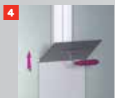
Aplicați încă un strat de ipsos de îmbinări sau ready-mix cu 50-60mm mai lat decât linia îmbinării și așteptați până la uscarea completă.
